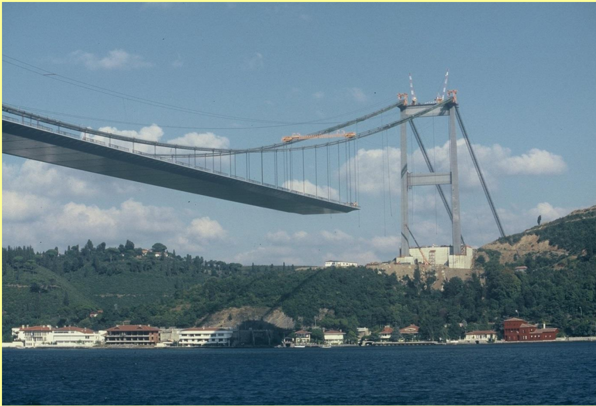
Ein schwieriger Brückenbau
