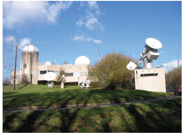
Satellitenbodenstation am Observatorium Lustbühel für die Frequenzbereiche 11/12/14 GHz
