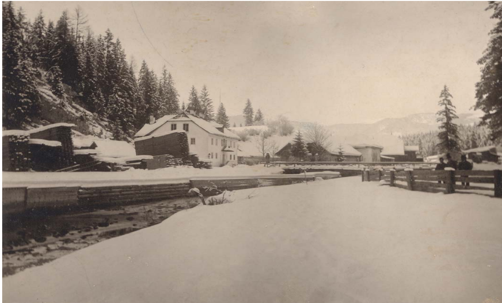
Sägewerk Pass Stein um 1900. An dieser Stelle Stand vorher ein großes Hammerwerk
