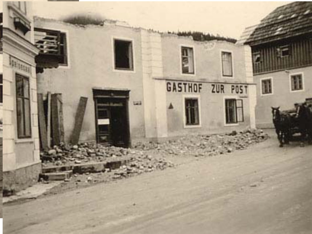
Beginn des Abbruchs des Gasthofs Post, weil die Straße für Militärfahrzeuge zu eng war! 1939
