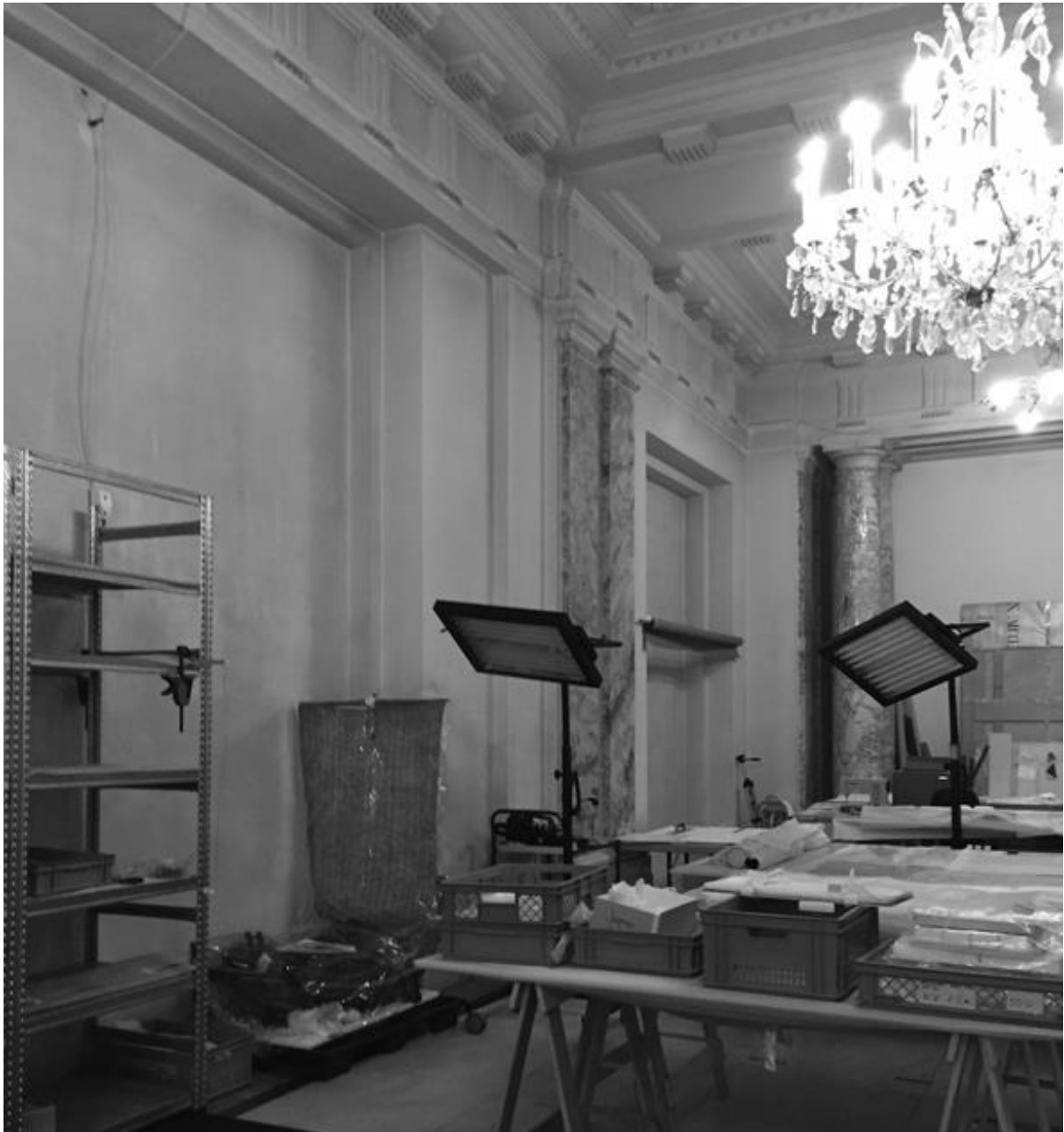
Abb.: Raum M006 (Bereich des künftig neu zu schaffenden Durchbruches zwischen „Jünglingsplateau“ und HGÖ) 9
