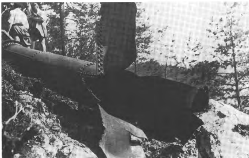
Die Ablichtung zeigt eine durch Bomben zerstörte Druckrohrleitung bei Kufstein. Original im Institut für Zeitgeschichte in Wien.
