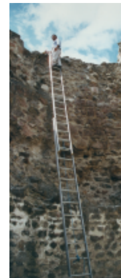
Mautern, Westmauer des römischen Kastells mit Fächerturm nach der Restaurierung (links)
