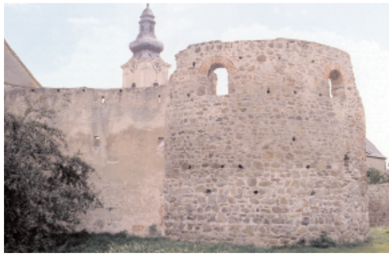
Mautern, Westfront des Kastells mit Hufeisenturm und Fächerturm
