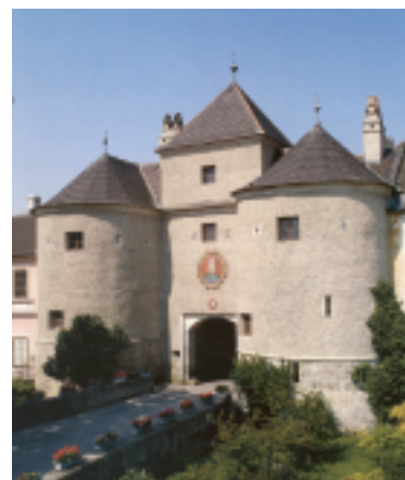
Traismauer, östliches Kastelltor
