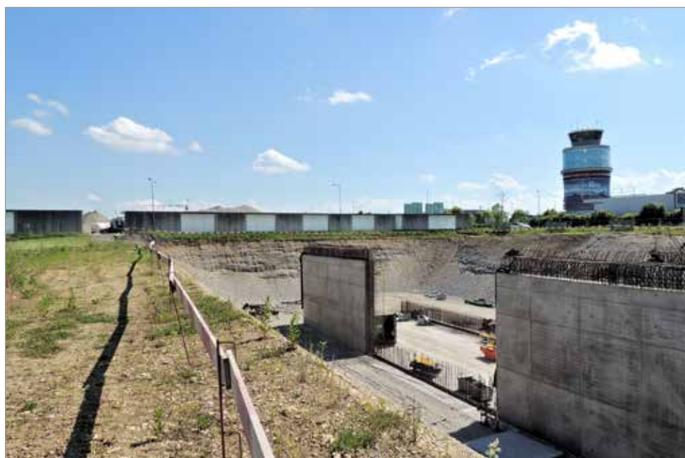
Die in offener Bauweise zu errichtende Unterflurtrasse unter dem Flughafengelände direkt vor dem Flughafen Graz. Nach derzeitigem Stand ist im Unterflurtunnel unter dem Flughafen keine Haltestelle geplant. Sie wird derzeit von der HL-AG nur so weit vorbereitet, dass eine Einrichtung zu einem späteren Zeitpunkt jederzeit möglich ist.
