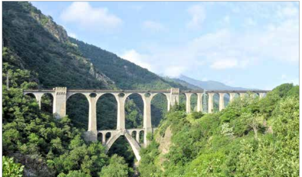
Das gemauerte, 237 m lange Viaduc Sejourne nahe Thues-Carenca.
