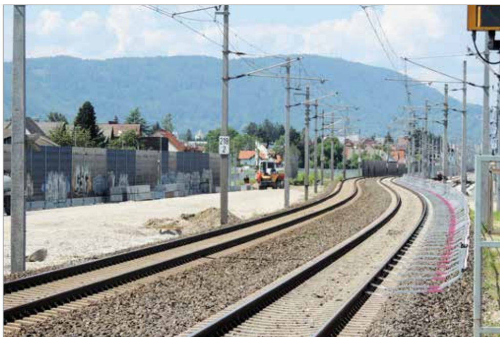
Die derzeitige Verschwenkung der Gleise aus Richtung Spielfeld-Straß von der zukünftigen Trasse des Nahverkehrs - im Hintergrund ist diese bereits weitgehend fertiggestellt. Ganz links liegen dann die zukünftigen Fernverkehrsgleise der Koralm-bahn Richtung Klagenfurt.
