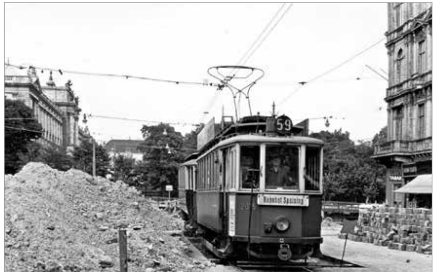
Der einziehende HVZ-Zug der Linie 59, G 2 2015+k 2 3333, hat gerade die Baustelle der Babenbergerpassage verlassen. Rechts sieht man noch die Behelfsbrücke zur Überquerung der Baugrube. Foto: Egbert Leister, 17.6.1960
