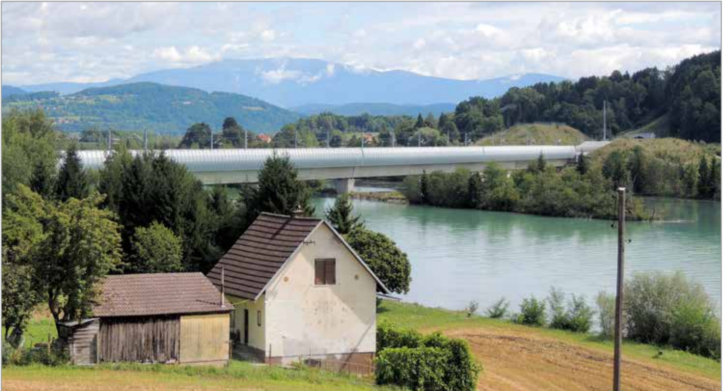
Die schon seit 2014 als Baustellenzufahrt bestehende neue Draubrücke, wo die anschließende Strecke teilweise den noch bestehenden Bahnhof Tainach-Stein in einem Tunnel unterfährt.
