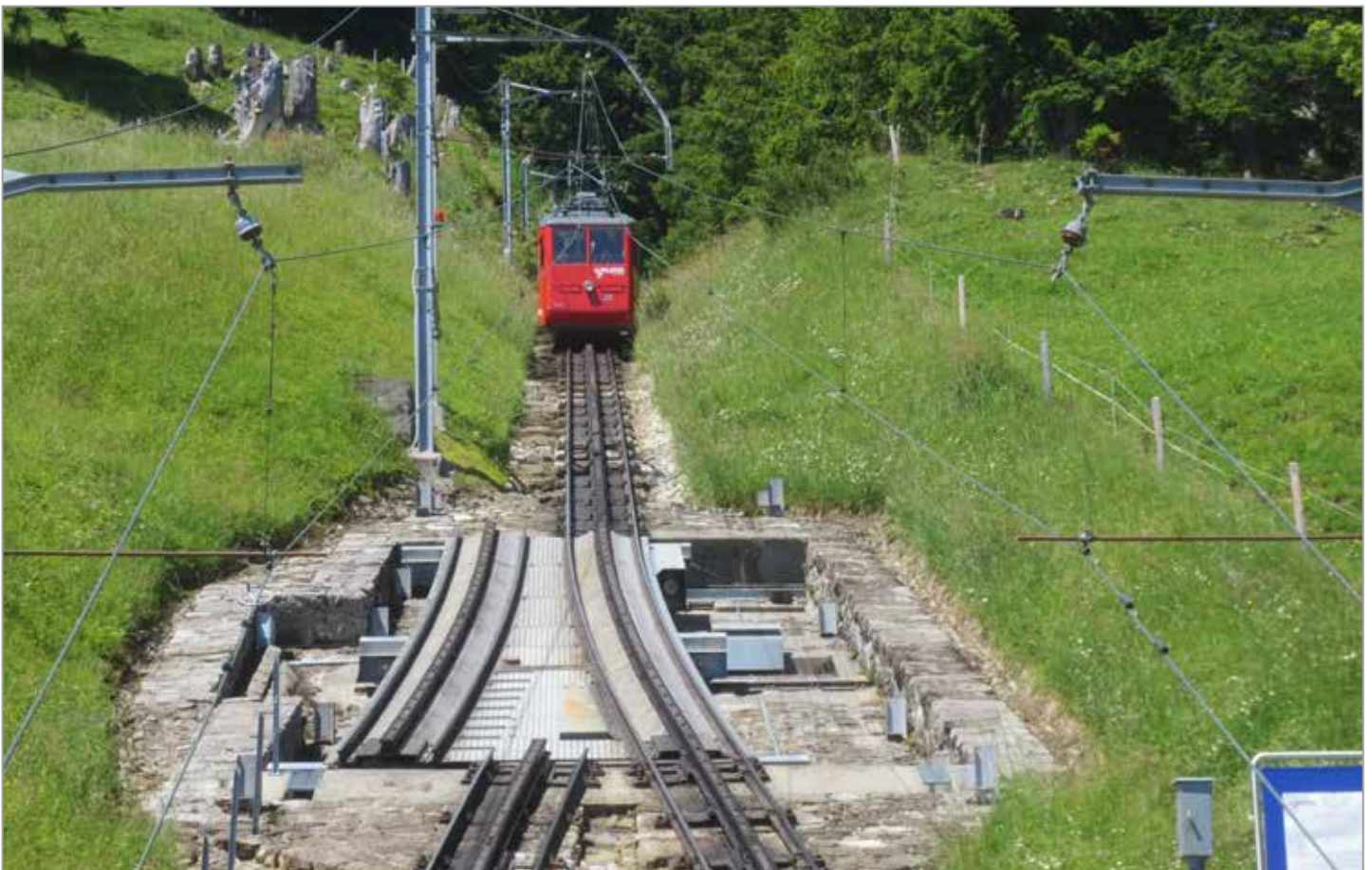
Der Blick auf die obere Schiebebühne der Zwischenstation Ämsigen offenbart die besondere Konstruktion der „Weiche“; im Hintergrund fährt der Wagen 23 weiter bergwärts.
