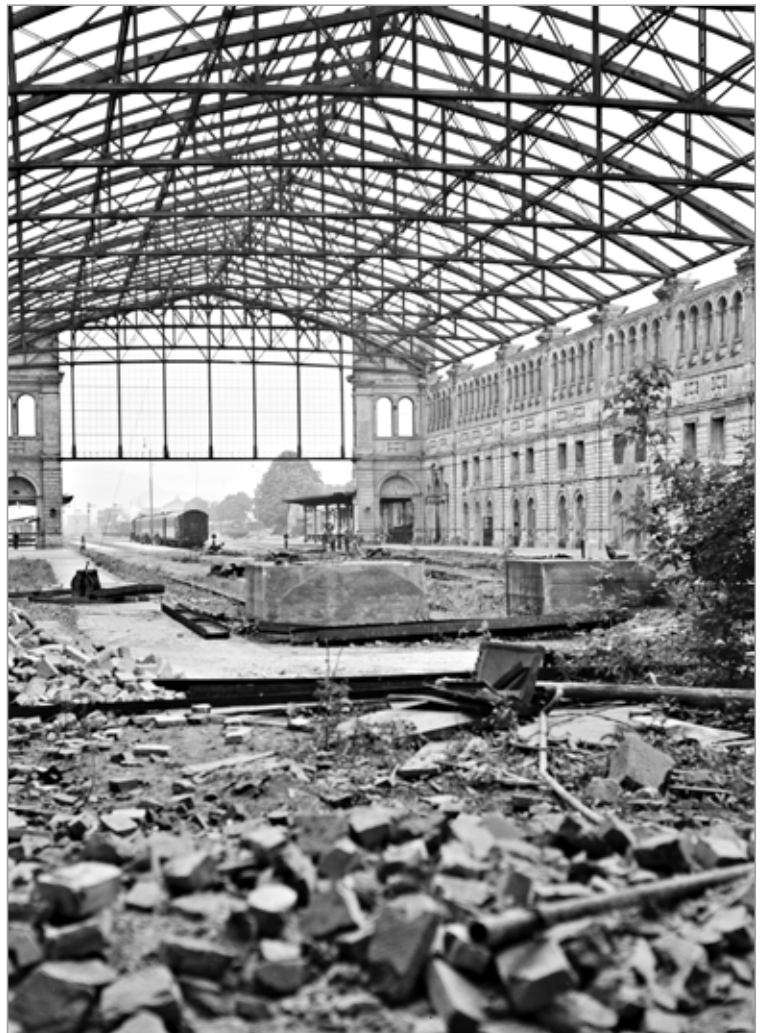
Im Mai 1952 nahm Fritz Schneeberger die leere, beschädigte Bahnhofshalle auf; der Schutt ist nur provisorisch beiseite geräumt. Der Reiseverkehr begann vor der Halle, der Zugang erfolgte vom seitlichen Abfahrtspavillon.
