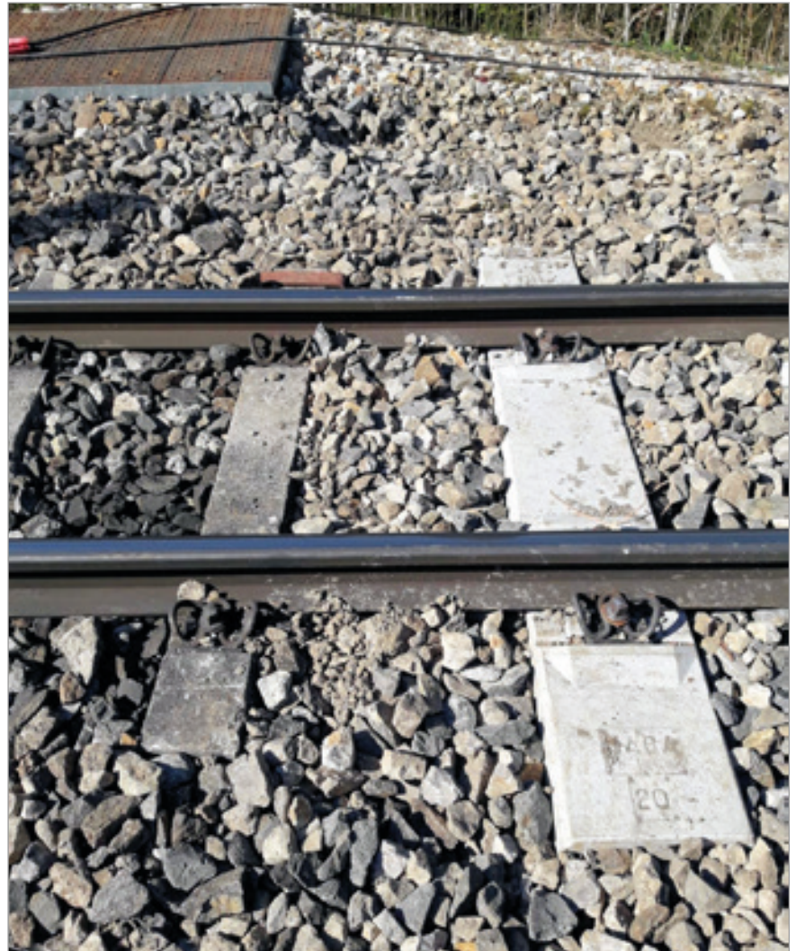
Ein Vergleich zwischen alten und neuen Schwellen zeigt den Größenunterschied. Foto: Tschudnig, NÖ Bahnen, 25.9.2022
