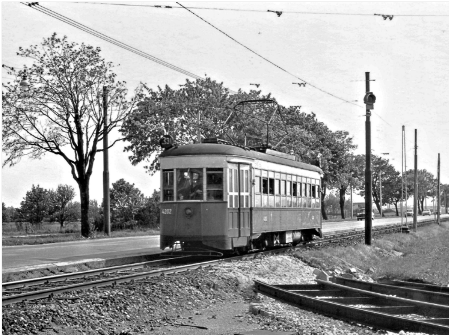
Der Z 4202 am 10. 04.1964 in Höhe der rechts sichtbaren Gleise der neuen Strecke auf die andere Seite des Lokalbahnhofes, die zur neuen Schleife führen werden.
