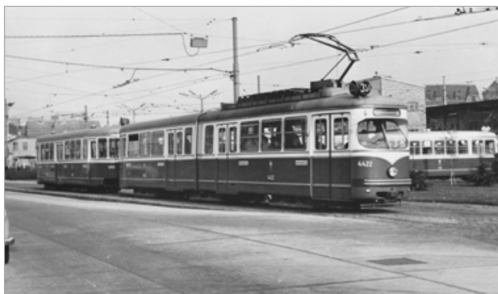
E 4422+c3 1284 vor der linken Schleife vor dem ÖBB-Bahnhof Floridsdorf am 1.11.1964. Diese „brustschwache“ Kombination war nicht lange im Einsatz.
