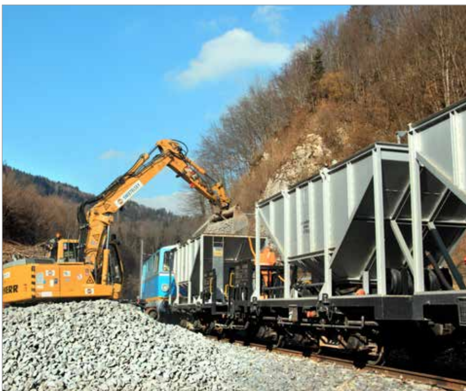
Ein wegen einer Kabeltrasse komplett vom Schotter geräumtes Stück zwischen Schwarzbach und Kirchberg an der Pielach wird wieder eingeschottert.
