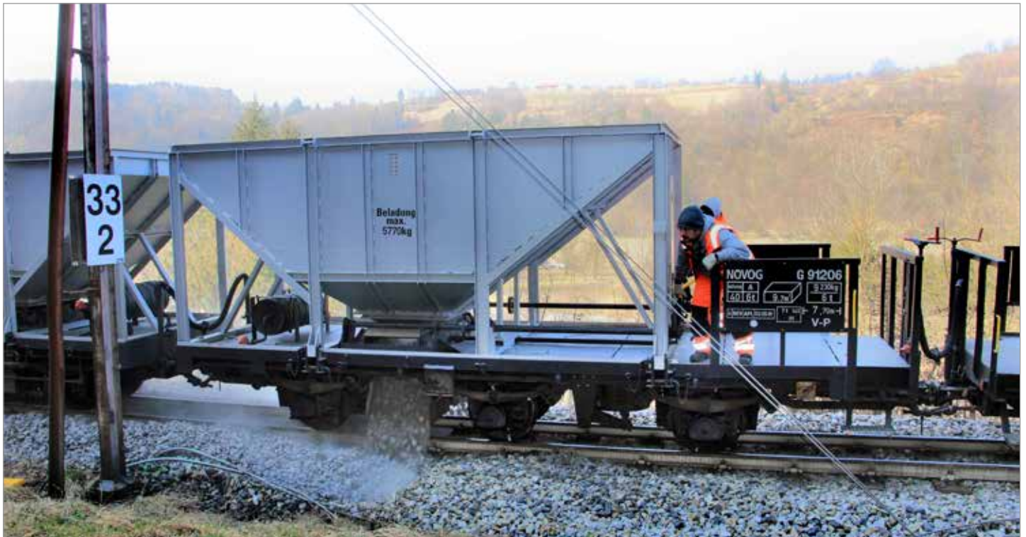
Ein wegen einer Kabeltrasse komplett vom Schotter geräumtes Stück zwischen Schwarzbach und Kirchberg an der Pielach wird wieder eingeschottert.
