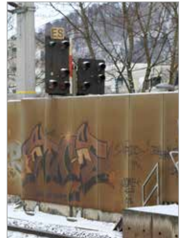
Ja wer schaut denn da über die Lärmschutzwand? Das ist das Einfahrsignal, allerhand!
