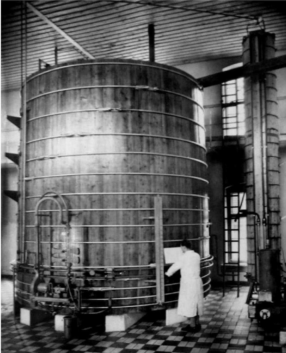
Abb. 1.6.1: Rechts ein schmaler hoher Versuchsständer, links ein Holzbottich mit Schnellvergärung durch Belüftungsvorrichtungen.
