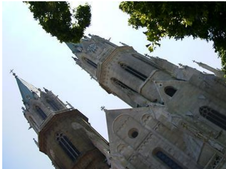
Blick auf die beiden Türme der Klosterkirche von der Hundskehle aus. Die unterschiedliche Farbgebung beider Türme weist auf verschiedene Bauphasen vor etlichen Jahrhunderten hin. Vor allem wurden verschiedene Steinarten verwendet – Foto: Ernst Zentner (22.06.2008 12:55)
