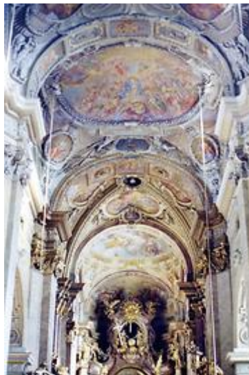
Stiftskirche, Innen, Langhaus, imposante Stuckdecke, geteilt durch Gurtbögen und Freskengewölbe – Foto: Ernst Zentner (August 1988)
