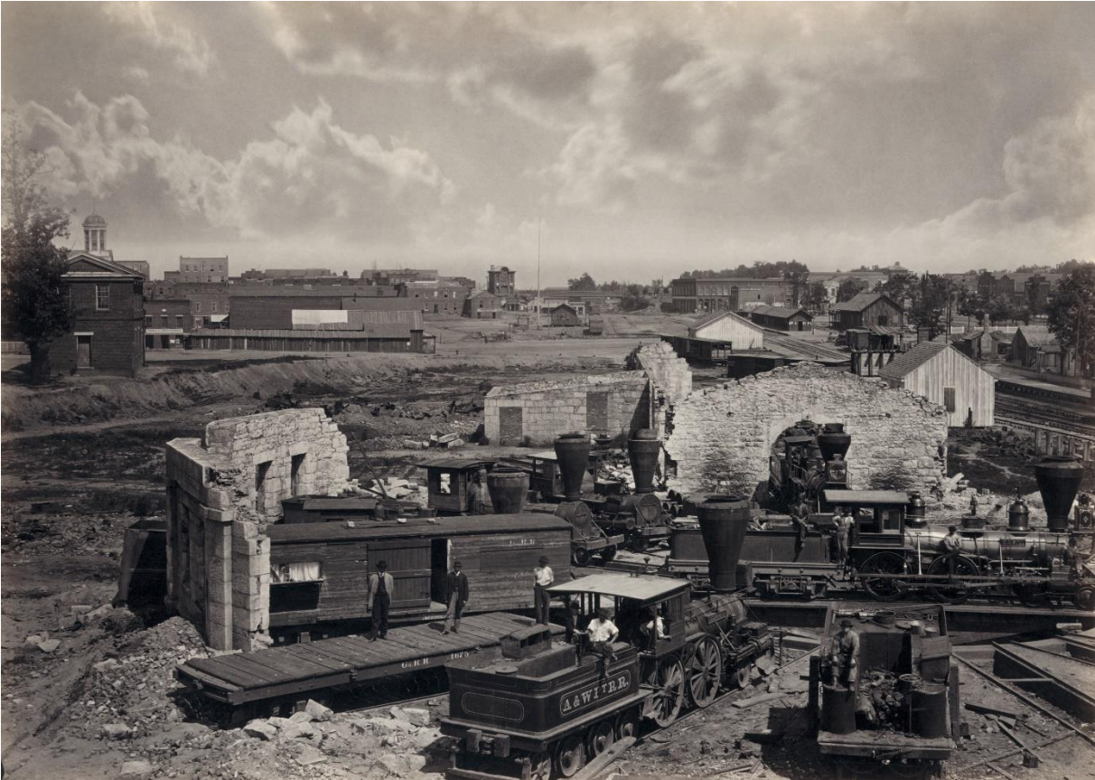
Beispiel der Zerstörung bei Atlanta. Hier die Ruinen eines Lokschuppen mit Drehscheibe – Foto: George N. Barnard, 1866 – Wikimedia Commons – Gemeinfrei
