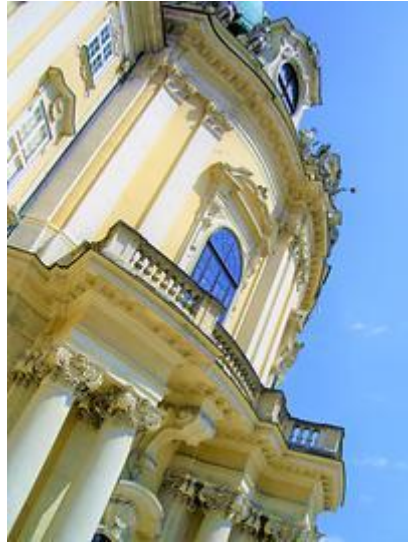
Fassade des Marmorsaales über dem Hauptportal bzw. Sala terrena – Foto: Ernst Zentner (22.06.2008 11:50)
