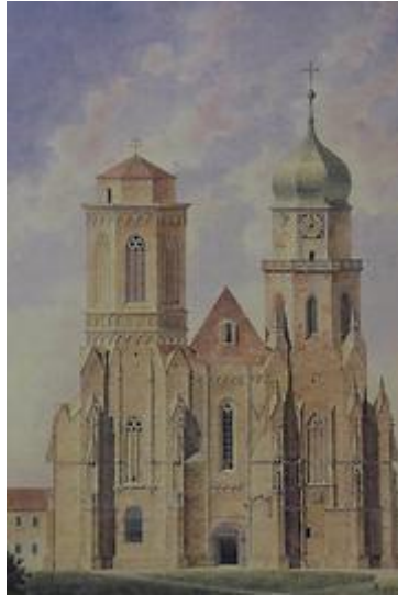
Stift Klosterneuburg, Fassade der Klosterkirche vor der neogotischen Rekonstruktion durch Friedrich von Schmidt – Foto: Oktobersonne, Wikimedia Commons – Gemeinfrei
