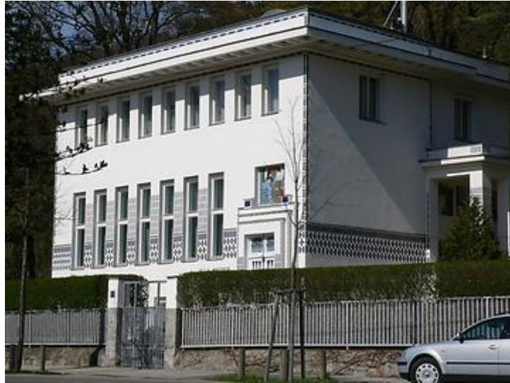
Otto Wagner Villa II, Wien-Penzing, Hüttelbergstraße 28. Wagners ureigenster Stil, erb. 1912/13 – Foto: Welleschik, Wikimedia Commons – Gemeinfrei
