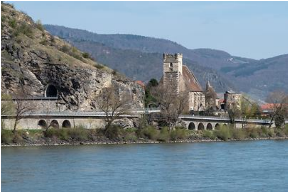
St. Michael an der Donau – Links das Tunnelportal der Wachaubahn (11.04.2018) – Foto: Isiwal Wikimedia Commons – Gemeinfrei
