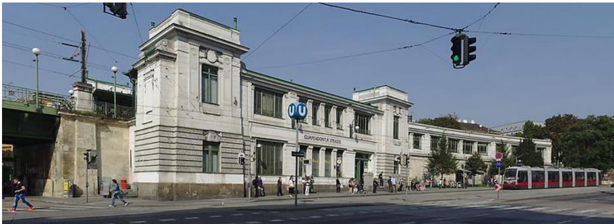
U-Bahn-Haltestelle Gumpendorfer Straße (ehem. Stadtbahn-Station), errichtet 1898 – Foto: Tokfo, Wikimedia Commons – Gemeinfrei
