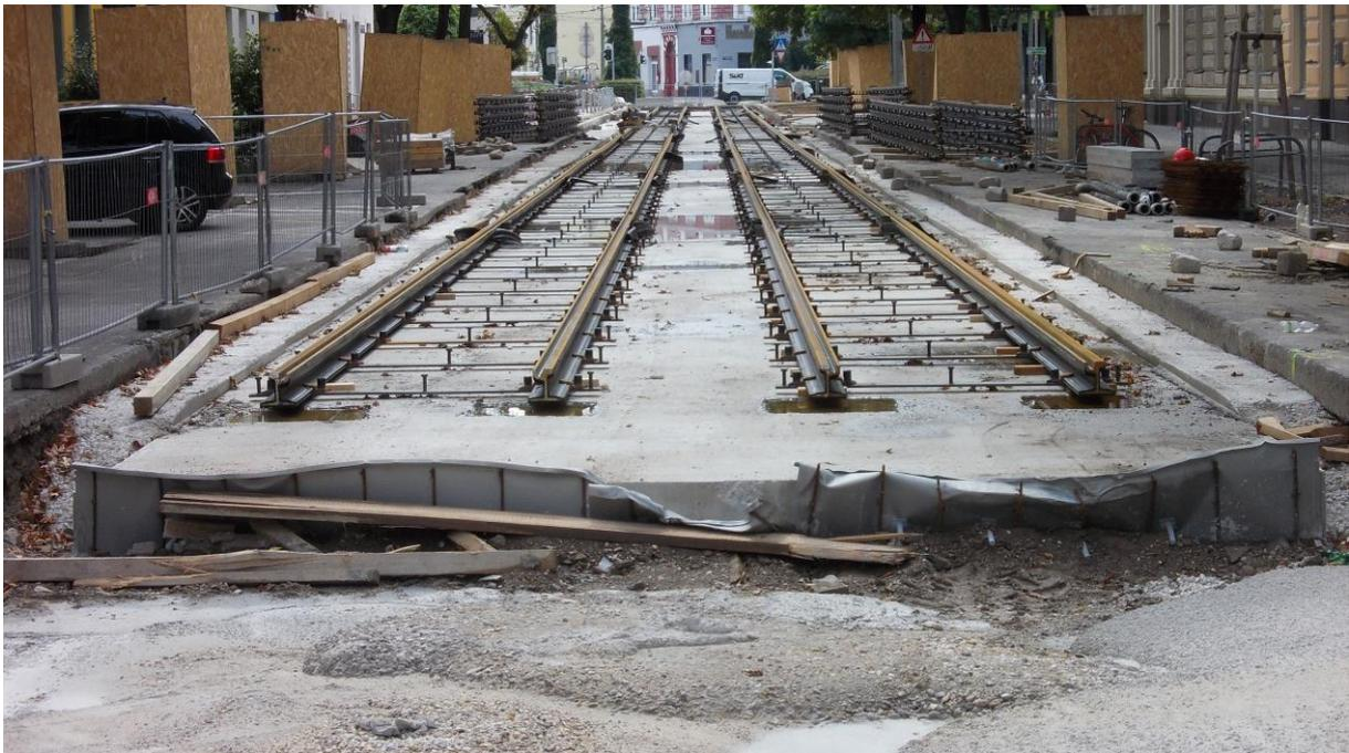
*Im überbreiten Gleistrog die neuen Rillenschiene auf frisch gegossenen Betonfundament – Blickrichtung Gaußplatz – Einzelne Wasserlachen weisen auf einen wenige Stunden niedergegangenen Regenguss hin – Beachtenswert auch diese hellbraunen Schutzkästen der Alleebäume (20. August 2017 11:46)*
