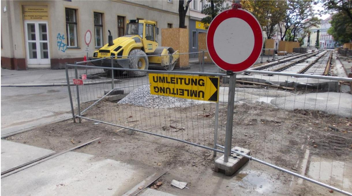
*Für den Pkw-Verkehr heißt das "Umleitung" – Hinten die neuen Gleise und vor dem Warnschild noch die alten Schienen, die ebenfalls gewechselt werden (20.08.2017 11:45)*
