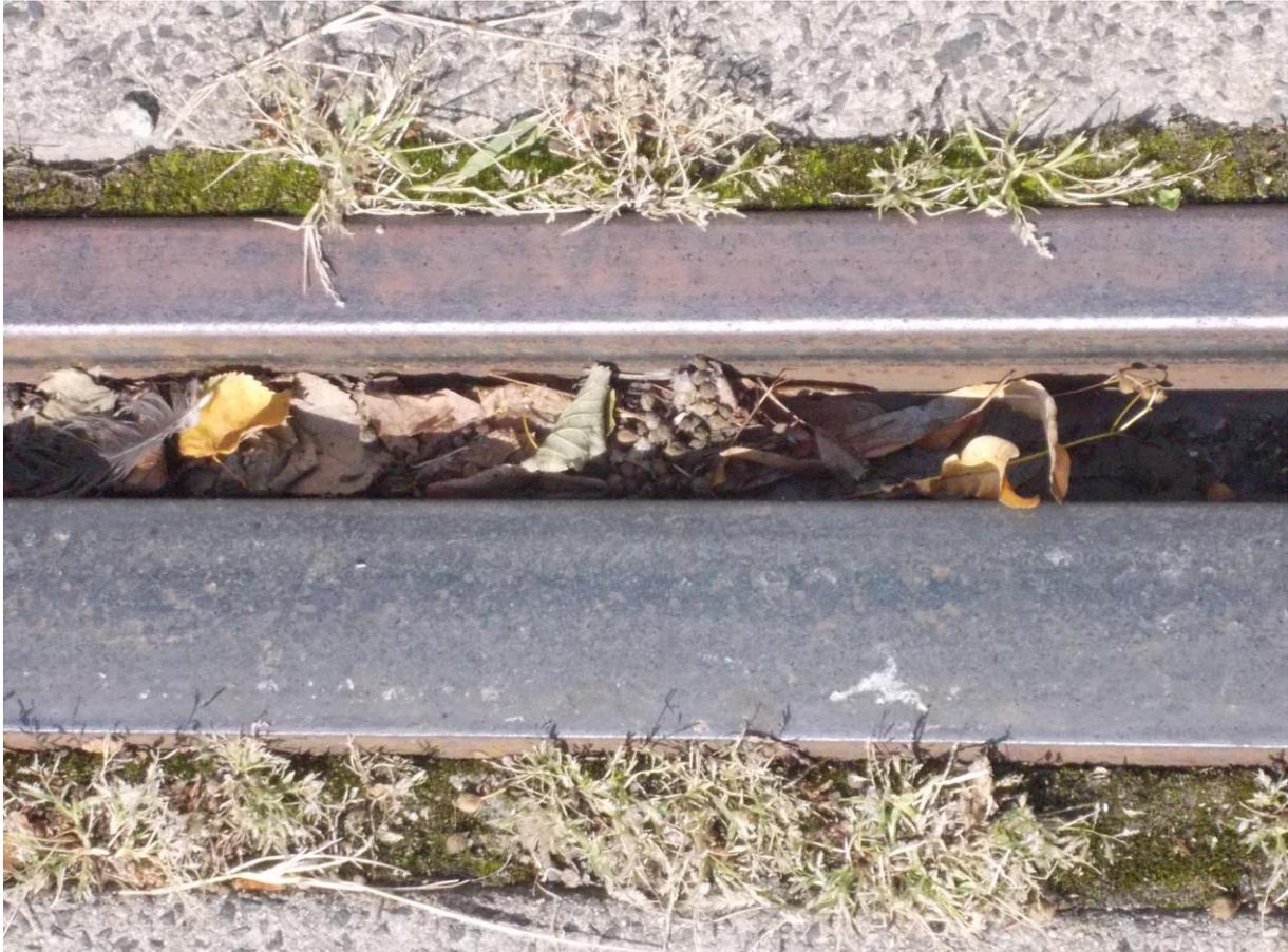
*Rillenschiene, ganz nahe – Manchmal steht auf diesem Gleis ein Sonderzug bestehend aus Oldtimern oder einfach nur ein pausierender "D"-Wagen (11.09.2016 11:36)*
