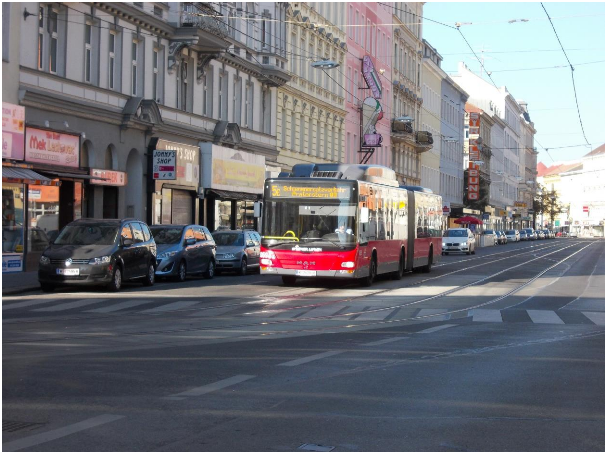
Wegen der imposanten Gleisbauarbeiten wurde der reguläre Straßenbahnbetrieb kurzzeitig mittels Gelenksautobus (Nr. 8069 – "5E Schienenersatzverkehr Praterstern S U") überbrückt. Eine absolute Seltenheit auf der 5er-Strecke (15. August 2017 08:24)
