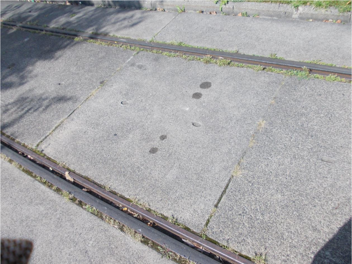
Rillenschienen, inmitten Betonplatten und einigen Schmierölflecken – leicht rostig. Nur ein Zeichen, dass dieses Gleis eher wenig beansprucht wird; Schleife (Linie D bei Kurzführung aus tausenderlei Dingen) am Schottenring, Wien-Innere Stadt (11.09.2016 11:36)
