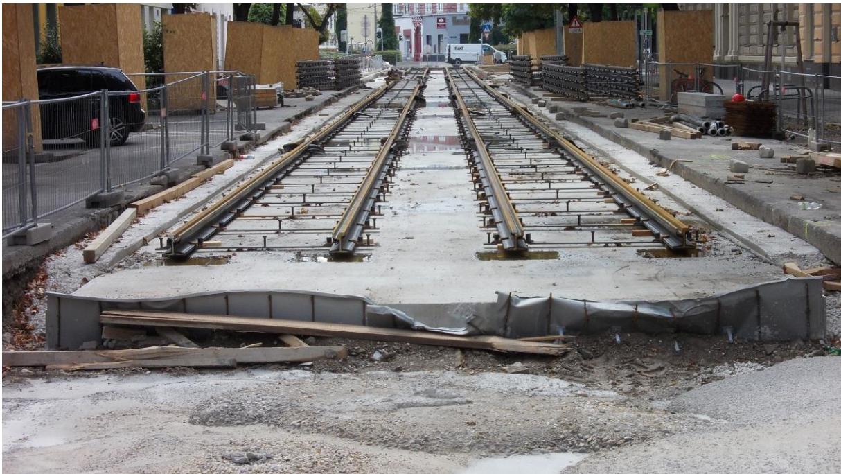
Im überbreiten Gleistrog die neuen Rillenschiene auf frisch gegossenen Betonfundament – Blickrichtung Gaußplatz – Einzelne Wasserlachen weisen auf einen wenige Stunden niedergegangenen Regenguss hin – Beachtenswert auch diese hellbraunen Schutzkästen der Alleebäume (20. August 2017 11:46)
