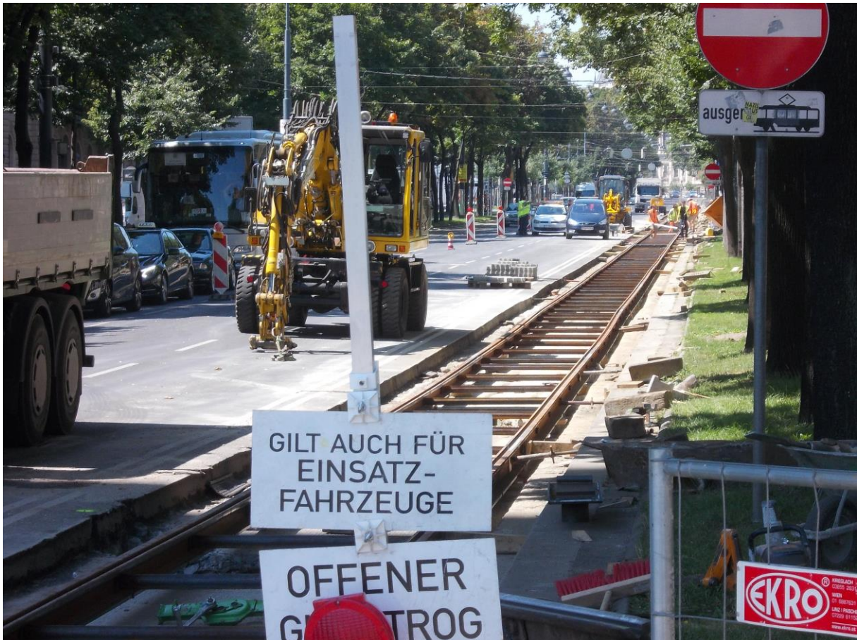
Gleiserneuerung, Schottenring, Richtung Universität (10. Juli 2016 11:37) – Im Hintergrund auf den Schienen ein Bauteam – Der altgewohnte Autoverkehr wird auf eine Spur begrenzt
