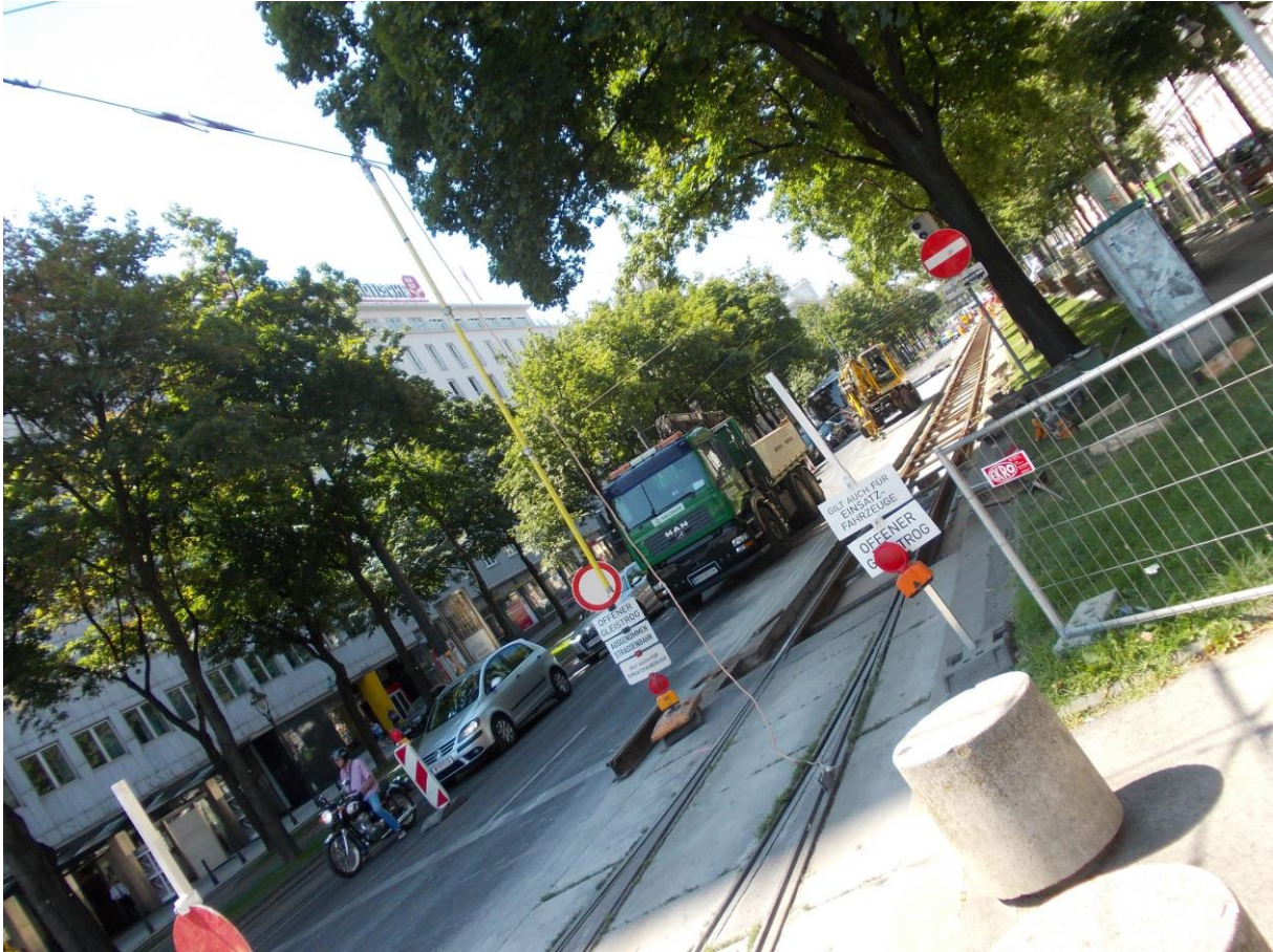
Gleiserneuerung am Schottenring neben dem Ringturm – Stau bzw. Einschränkungen des Pkw-Verkehrs. Auch temporär stillgelegte Straßenbahnstrecke – Hier wird eindringlich vor dem Gleistrog gewarnt (10. Juli 2016 11:37)
