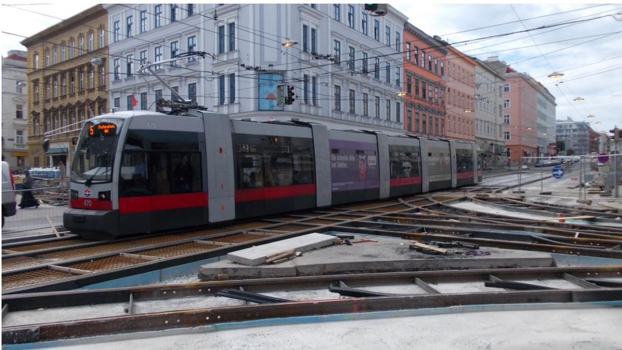
Der ULF 670 – Linie 5 Richtung Praterstern – rumpelt vorsichtig über die neue Gleiskreuzung (mit Weichen) (20.08.2017 11:51)
