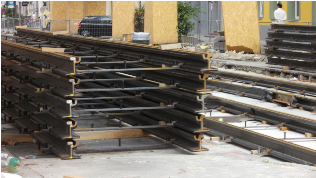
Hier aufgestapelt die neuen Gleissegmente (20.08.2017 11:42)
