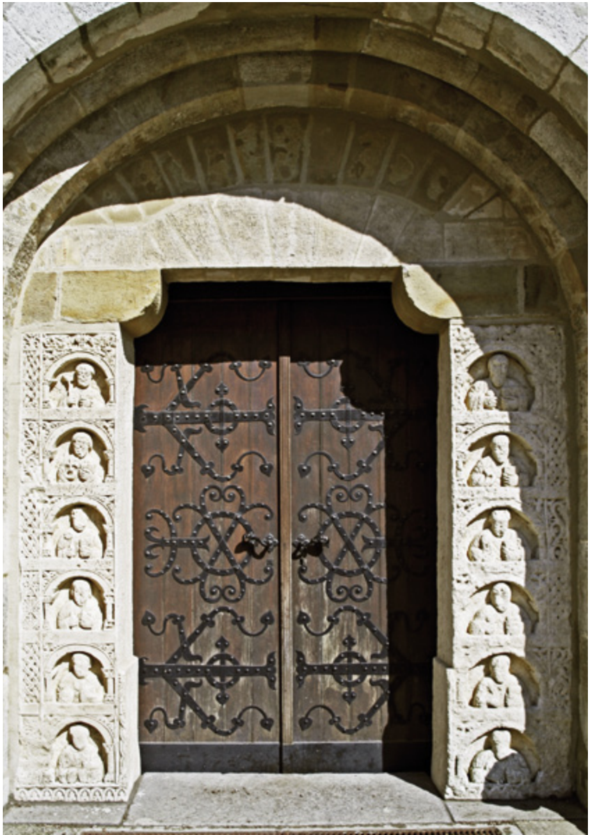
Abb. 10: Westportal der Pfarrkirche Tulln
