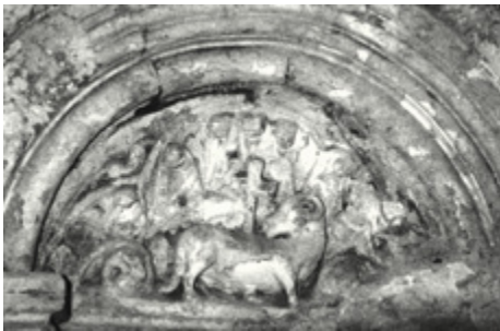
Abb. 57: Nordportal in das Querhaus der Michaeler- kirche in Wien
