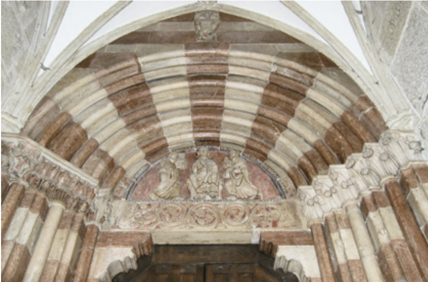
Abb. 15: Detail des Südportals der Franziskanerkirche in Salzburg
