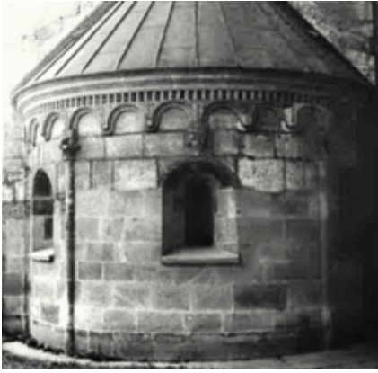
Abb. 103: Süddaps der Pfarrkirche in Himberg. Ansicht von Osten
