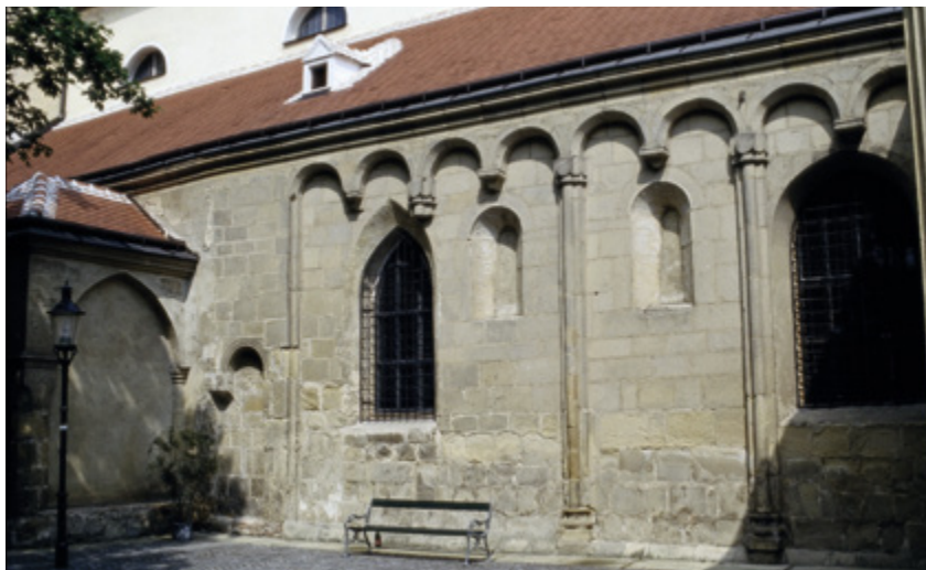
Abb. 9: Südliche Seitenschiffwand der Pfarrkirche Tulln
