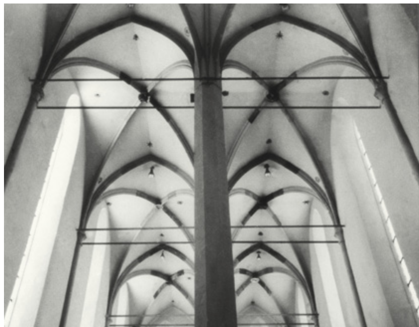
Abb. 218: Gewölbe der ehem. Dominikanerinnenkirche in Imbach
