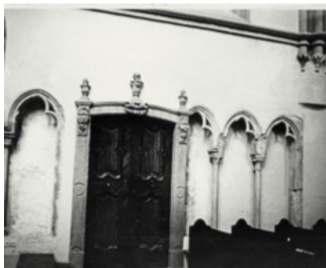
Abb. 207 a und b: Freigelegte Sedilien im Chor der „Liebfrauenkirche“ in Wiener Neustadt, Ansicht und Plandarstellung
