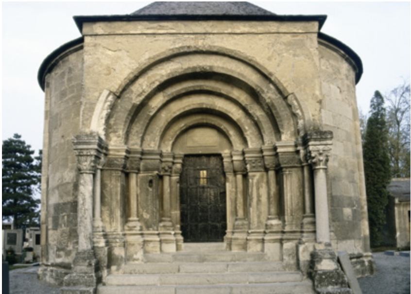
Abb. 105 a und b: Portal des Kärners in Bad Deutsch Altenburg. Ansicht und Plandarstellung
