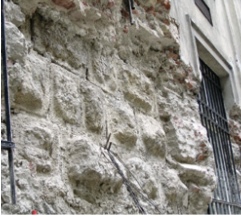
Abb. 112: Freigelegtes Buckelquaderwerk im Schweizertrakt der Wiener Hofburg
