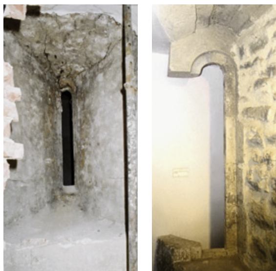
Abb. 111 a und b: Freigelegte romanische Fenster im Schweizertrakt der Wiener Hofburg
