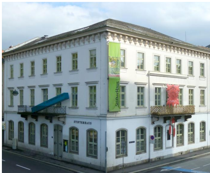
Wohnhaus Stifiers (ehem. Hartl'sches Haus), Linz, Adalbert Stifter - Platz Nr.1; Foto Schäffer 2011
