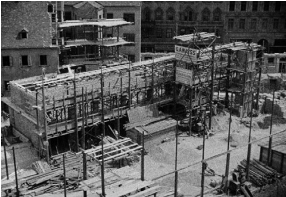
Abb. 21 Der Abriss verkehrsbehindernder Häuser und deren Neubau waren der Inhalt der ständestaatlichen Assanierungspolitik. Hier ist der Straßendurchbruch der verlängerten Operngasse im Freihaus-Viertel zu sehen. (Anonym um 1935).
