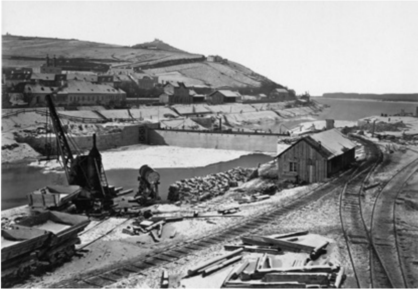
Bild Nr. 21. Kramer, Oscar: Die Absperrvorrichtung des Donaukanals im Bau 1874
