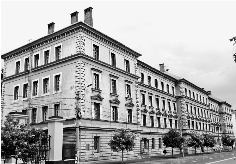
Abbildung 6: K. u. k. Franz Josefs-Artillerieskaserne, Hauptgebäude, Hermannstadt, 1872–1876.
