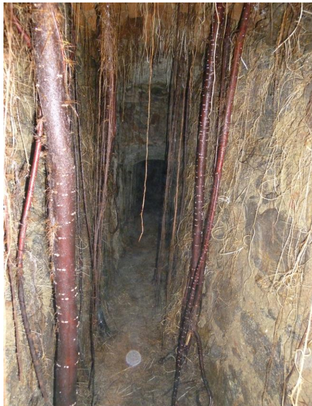
Fluchtstollen, ca 10m geradeaus verlaufend, dann Knick nach links (Süden), 28. Juli 2011, Foto Schäffer
