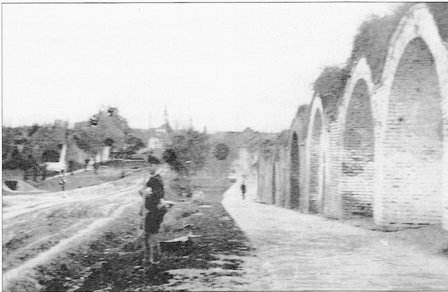
Eiskeller am Kerchhofsberg, von Norden nach Süden gesehen.
