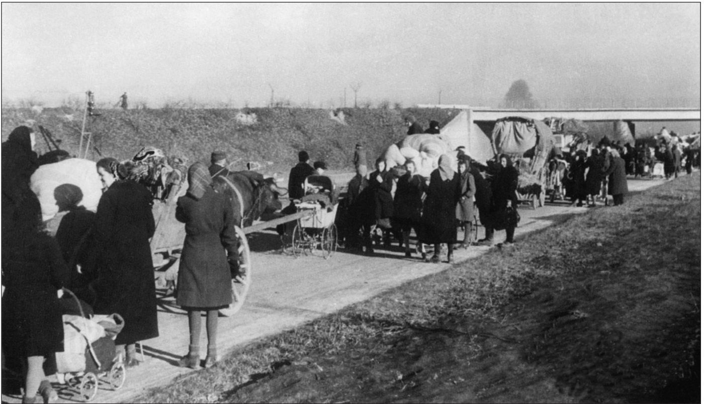
Einst Hitlers Stolz – die unfertige Autobahn vor Breslau. 1945 diente sie als Nachschub- und Fluchtweg gleichermaßen.
