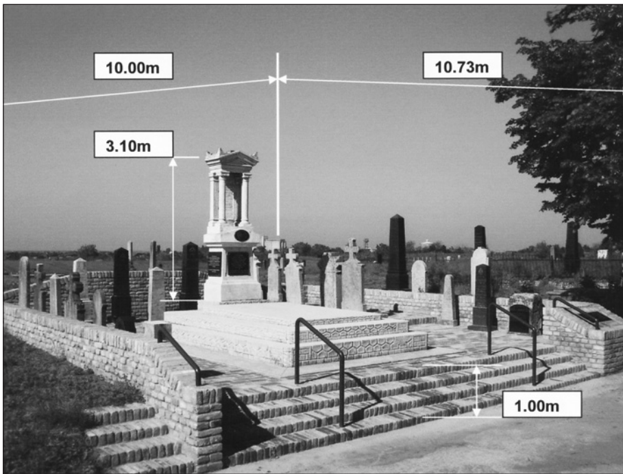
Bauausführung der Toten-Gedenkstätte in Crvenka
