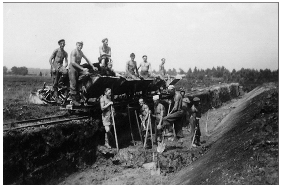
Die ersten Kanäle wurden per Hand gegraben
