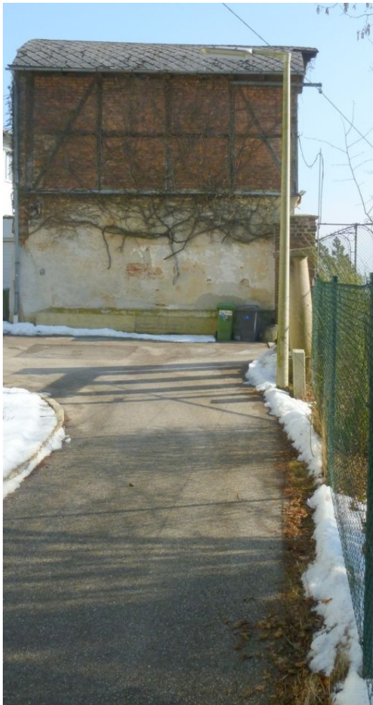
Blick auf Umkehrplatz und Gerichtssäulen aus westlicher Sicht (Richtung ehem. Maut-Häuschen); Foto Schäffer, 2010
