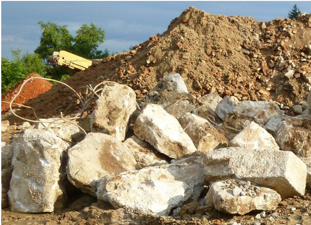
Aushub-Reste der Bodenplatte des ehemaligen Schlossgebäudes Hagen, v.m Teile eines Steinkreises (s.u.); Foto Schäffer, 18. Juli 2011
