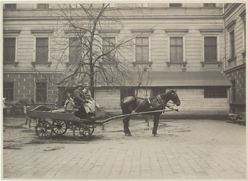
Abb.: Fuhrwerk vor der Küchenbaracke im ersten Innenhof (StLB).
