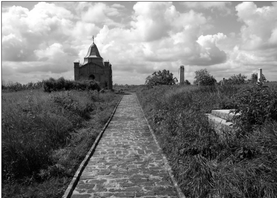
Zugang zur restaurierten Gruft Christ/Fuchs 2010
