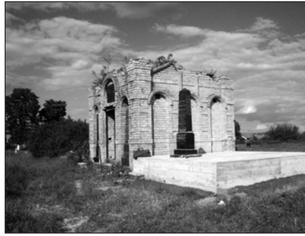
Stand 2008: Gruft Fuchs, Sanierung begonnen
