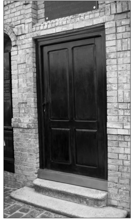
Detail: Neuer Eingang an Kapelle, Mai 2010
