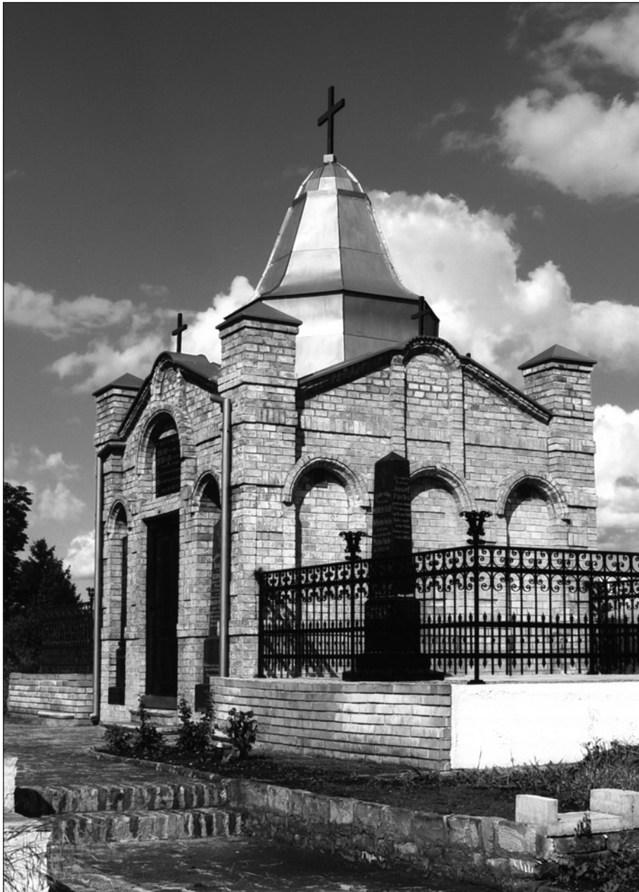
Die Kapelle mit den Gruften der Familien Christ/Fuchs nach der Restaurierung
