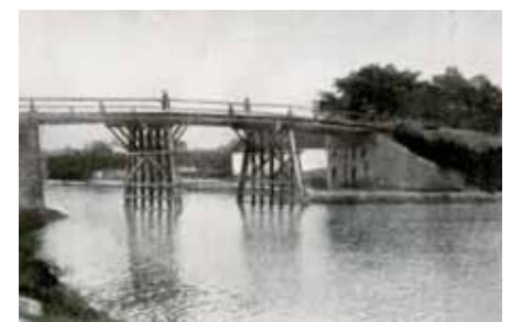
Hohe Brücke in Holzkonstruktion
