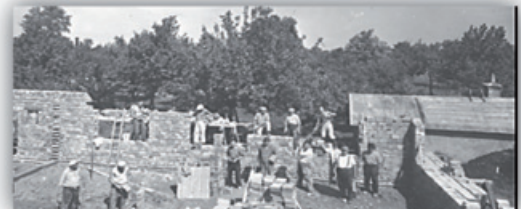
Gegenseitige Hilfe beim Hausbau
